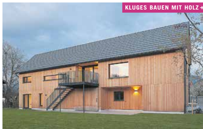
Objekt Ein Haus im Corn-Feld Bauherrschaft Anonym Architektur Gamsfels Architektur GmbH, Lochau Holzbau Zimmerei Berchtel GmbH, Schnifis
