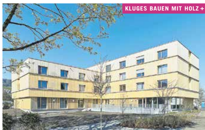
Objekt Pflegeheim St. Josefs Haus, Gaißau Bauherrschaft Liebenau Österreich gemeinnützige GmbH Architektur Johannes Kaufmann und Partner GmbH, Dornbirn Holzbau Kaufmann Zimmerei und Tischlerei GmbH, Reuthe
