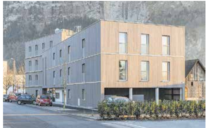
Objekt Transfer Wohnraum Vorarlberg Froschweg Bauherrschaft Wohnbauselbsthilfe Vorarlberg, Dornbirn Architektur Hermann Kaufmann + Partner ZT GmbH, Konrad Duelli Architekt, Andreas Postner Holzbau Fritz Holzbau GmbH, Bartholomäberg
