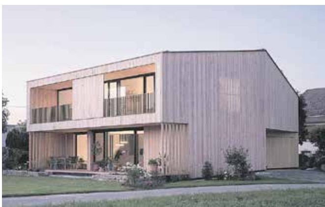
Objekt EFH Gmeiner Bauherrschaft Margrit und Andreas Gmeiner, Lustenau Architektur querschnitt architekten zt gmbh, Wolfurt Holzbau Dobler Holzbau GmbH, Röthis
