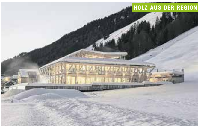
Objekt Hotel Hubertus Mountain Refugio Bauherrschaft Traubel Immobilien OHG, Balderschwang (D) Architektur Beer Bemé Dellinger Architekten, Greifenberg (D) Stadtplaner GmbH, Greifenberg (D) Holzbau Sohm HolzBautechnik GmbH, Alberschwende
