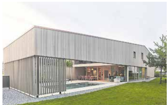
Objekt Haus am Mähdle Bauherrschaft Anonym Architektur Bertold Weber Architekten, Dornbirn Holzbau Kaspar Greber Holz- und Wohnbau GmbH, Bezau
