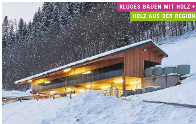
Objekt © Bergholz-Berglandwirtschaft Bauherrschaft Chantal und Thomas Heiseler, Sonntag Architektur Hammerer Architekten GmbH, Ludesch Holzbau Zimmerei Heiseler GmbH & Co. KG, Sonntag
