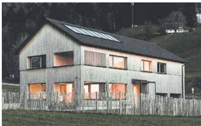
Objekt EFH Junge Linde Bauherrschaft Anonym Architektur häusler bau und architektur gmbh, Riefensberg Holzbau Zimmerei Gerhard Bilgeri GmbH, Riefensberg
