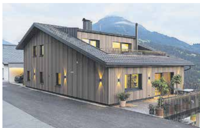
Objekt Umbau/Sanierung MFH Thüringerberg Bauherrschaft Anonym Architektur PD - Innenarchitektur, Ing. Patrick Dür, Bludenz Holzbau Sutter Holzbau GmbH, Ludesch
