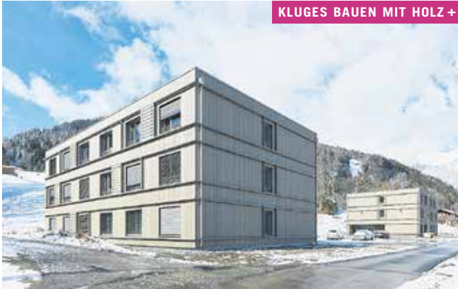
Objekt Personalhaus Latschau, Tschagguns Bauherrschaft illwerke vkw AG, Bregenz Architektur Johannes Kaufmann und Partner GmbH, Dornbirn Holzbau Kaufmann Bausysteme GmbH, Reuthe
