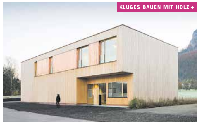
Objekt Firmengebäude PÖZ Bauherrschaft PÖZ Parkett & ökologischer Wohnbedarf Handels- und Beratungs GmbH, Hohenems Architektur Architektur | Baumanagement Haller Jürgen, Mellau Holzbau Zimmerei Joe Moosbrugger, Hohenems
