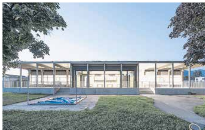
Objekt Kindergarten Merowinger Bauherrschaft Marktgemeinde Rankweil Architektur querschnitt architekten zt gmbh, Wolfurt Holzbau Kaspar Greber Holz- und Wohnbau GmbH, Bezaun
