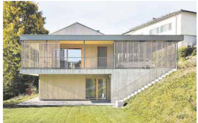
Objekt EFH S Bauherrschaft Anonym Architektur atelier rainer+amann-zt gmbh, Feldkirch Holzbau Martin Holzbau GmbH & Co. KG, Dornbirn
