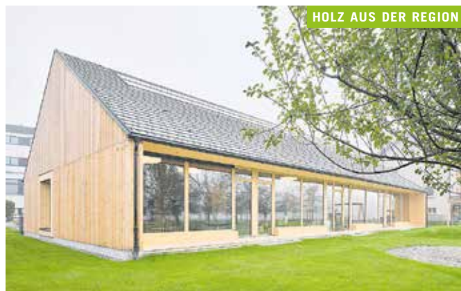
Objekt Hofkindergarten Rheinhof Bauherrschaft Stadt Hohenems Architektur MWArchitekten, Hohenems Holzbau Fussenegger Holzbau GmbH, Dornbirn
