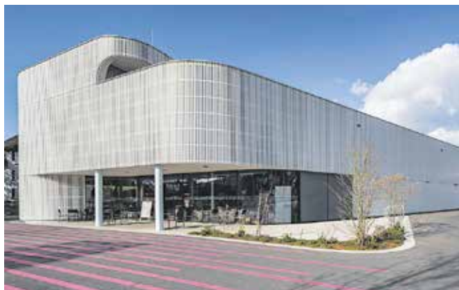
Objekt Sutterlüty, Frastanz Bauherrschaft Sutterlüty Handels GmbH, Egg Architektur Hermann Kaufmann + Partner ZT GmbH, Schwarzach Holzbau Fetz Holzbau GmbH, Egg
