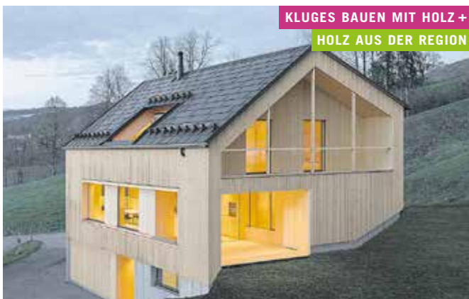
Objekt EFH Zimmermann Bauherrschaft Pia und Daniel Zimmermann, Egg Architektur Guter-Plan ZB GmbH, Egg Holzbau Fetz Holzbau GmbH, Egg
