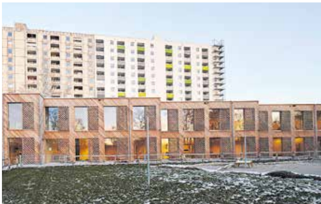
Objekt Kita Folsterhöhe, Saarbrücken (D) Bauherrschaft Landeshauptstadt Saarbrücken – Die Oberbürgermeisterin Architektur NKBAK Architekten, Frankfurt am Main (D) Holzbau Kaufmann Bausysteme GmbH, Reuthe
