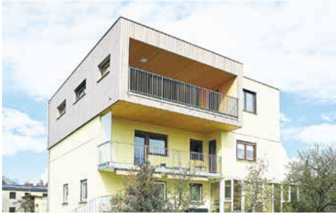
Objekt Aufstockung S Bauherrschaft Anonym Architektur DI Hebein Udo, Wolfurt Holzbau Berchtold GmbH & Co. KG, Wolfurt
