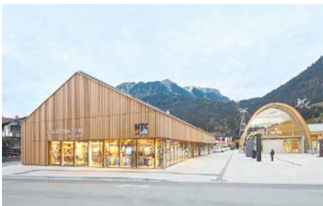
Objekt Nebelhornbahn Talstation, Oberstdorf Bauherrschaft Nebelhornbahn-AG, Oberstdorf (D) Architektur Hermann Kaufmann + Partner ZT GmbH, Schwarzach Holzbau Fetz Holzbau GmbH, Egg
