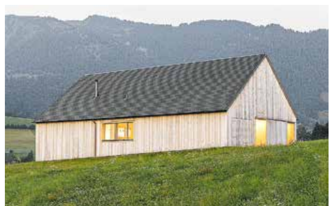
Objekt Haus Buchen Bauherrschaft Anonym Architektur Bernardo Bader Architekt ZT GmbH, Bregenz Holzbau Holzbau Hirschbühl, Riefensberg
