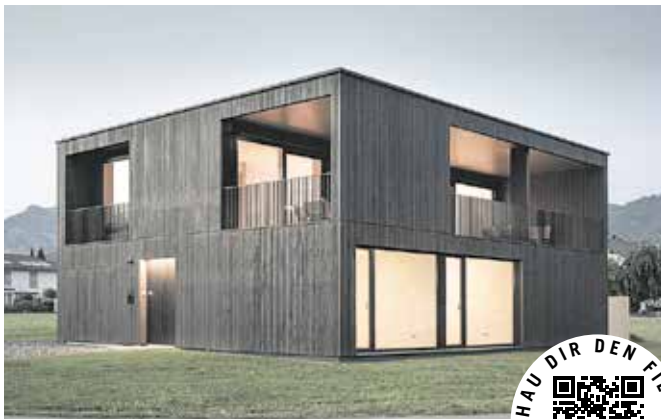
Objekt Offener Wohnraum Bauherrschaft Patrick Bauer, Rankweil Architektur querschnitt architekten zt gmbh, Wolfurt Holzbau Flatz Holzbau GmbH & Co. KG, Alberschwende
