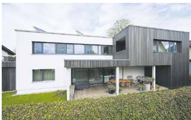
Objekt EFH Lunardi Bauherrschaft Nicol und Simon Lunardi, Dornbirn Architektur Planungs- und Zeichenbüro Brunold Thomas, Dornbirn Holzbau Holzbau Muxel Stephan GmbH, Au
