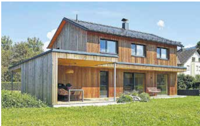
Objekt EFH M Bauherrschaft Anonym Architektur DI Hebein Udo, Wolfurt Holzbau Berchtold GmbH & Co. KG, Wolfurt
