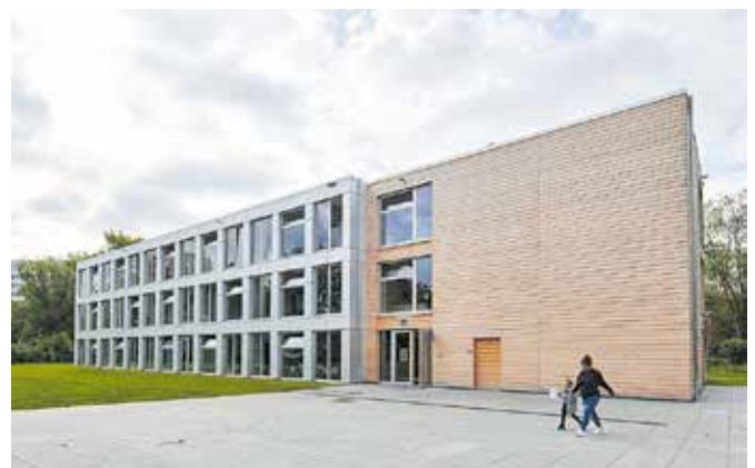
Objekt HOME B Schulen, Berlin Bauherrschaft Senatsverwaltung für Stadtentwicklung & Wohnen, Berlin (D) Architektur NKBAK Architekten, Frankfurt am Main (D) Holzbau Kaufmann Bausysteme GmbH, Reuthe
