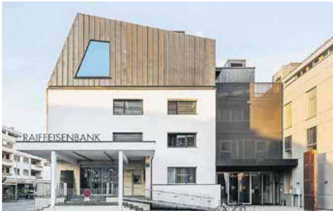
Objekt Aufstockung Raiffeisenbank Bodensee Leiblachtal, Hard Bauherrschaft Raiffeisenbank am Bodensee, Hard Architektur Früh Architekturbüro ZT GmbH, Hard Holzbau i+R Holzbau GmbH, Lauterach
