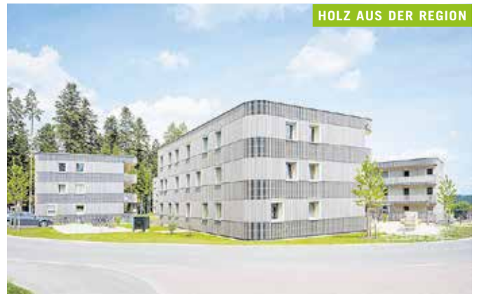
Objekt MFH HT C Bauherrschaft Hoffnungsträger Projektentwickler GmbH, Leonberg (D) Architektur andOFFICE Architekten, Stuttgart (D) Holzbau Sohm HolzBautechnik GmbH, Alberschwende
