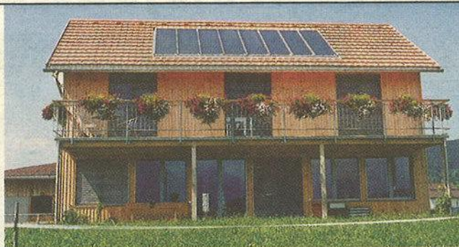
Bauherr: Julietta Lins u. Martin Türtcher, Satteins Planung: MM3 Simma-Rümmele, Dornbirn Holzbaubetrieb: Rheinhaus Holzbau GmbH & Co., Dornbirn
