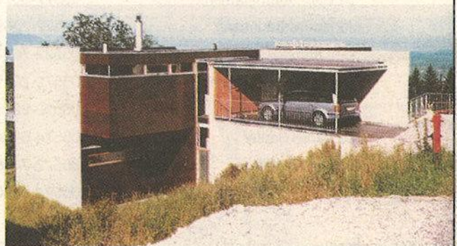
Bauherr: Edith u. Mario Moranduzzo, Möggers Planung: Daniel Sauter, Bregenz Holzbaubetrieb: Holzbau Gebr. Hehle GesBR., Hörbranz
