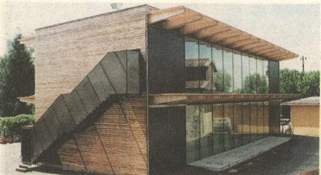
Bauherr: Stadt Bregenz, Bregenz Planung: Baumschlager & Eberle, Lochau Holzbaubetrieb: Holzbau Kaspar Greber GmbH, Bezau
