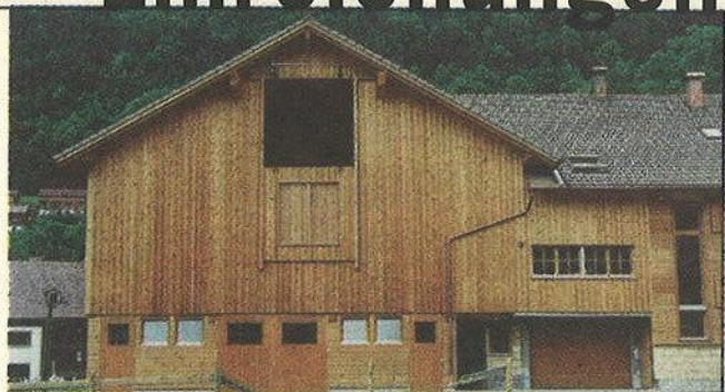
Bauherr: Jodok Natter, Bezau Planung: Klaus Sutterlüty, Bregenz Holzbaubetrieb: Holzbau Kaspar Greber GmbH, Bezau
