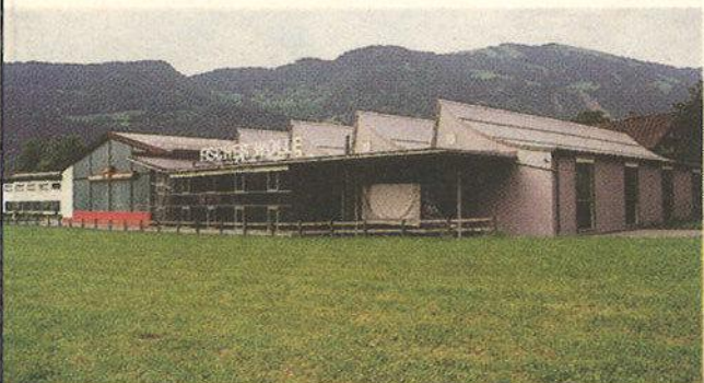
Bauherr: Kurt Fischer, Bezaú Planung: Leopold Kaufmann, Dornbirn Holzbaubetrieb: Holzbau Kaspar Greber GmbH, Bezaú
