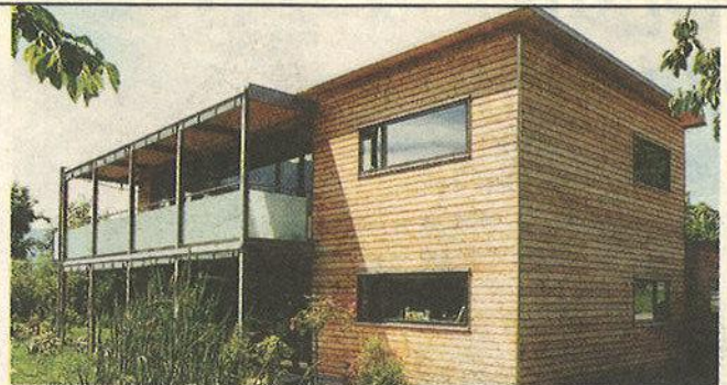
Bauherr: Thomas Mähr, Schlins Planung: Chr. Walch, VlbG. Ökohaus GmbH, Ludesch Holzbaubetrieb: Chr. Walch, VlbG. Ökohaus GmbH, Ludesch
