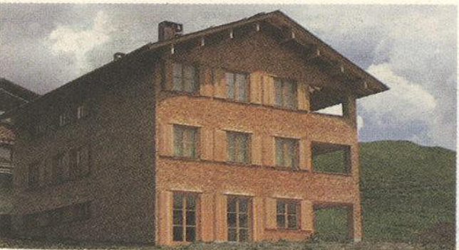
Bauherr: Hanno Martin, USA Planung: Nägele & Waibel, Dornbirn Holzbaubetrieb: Martin Holzbau GmbH & Co., Dornbirn
