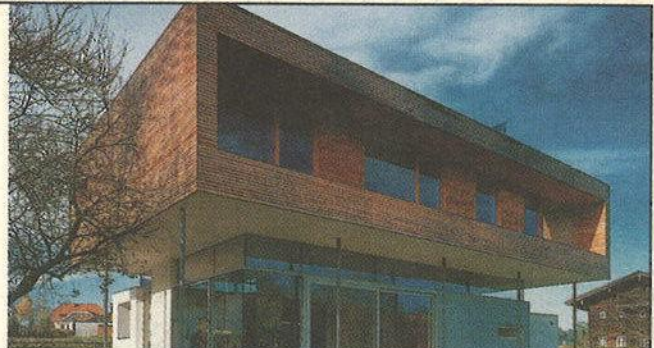
Bauherr: Fam. Süß-Amon, Taufkirchen Planung: Reisinger/Scheurecker, Wien Holzbaubetrieb: Berlinger Holzbau GmbH, Alberschwende
