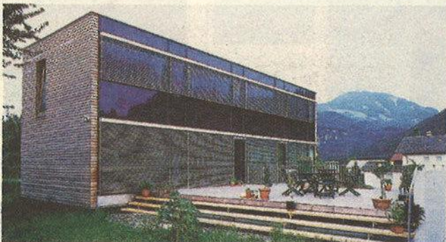
Bauherr: Eveline und Rainer Nägele, Göfis Planung: Johannes Nägele, Innsbruck Holzbaubetrieb: Neuhauser Holzbau, Nenzing
