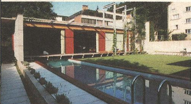
Bauherr: Bernhard Cerkel, Feldkirch-Tisis Planung: Wolfram Knall, Feldkirch-Tisis Holzbaubetrieb: Wucher Holzbau GmbH & Co. KG, Ludesch
