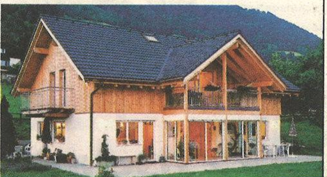
Bauherr: Herbert Dünser, Schnifis Planung: Aktiv Baupartner GmbH, Rankweil Holzbaubetrieb: Zimmerei Thomas Berchtel, Schnifis
