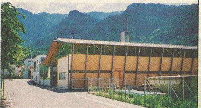
Bauherr: Stadt Hohenems, Hohenems Planung: Reinhard Drexel, Hohenems Holzbaubetrieb: I+R Schertler GmbH, Lauterach
