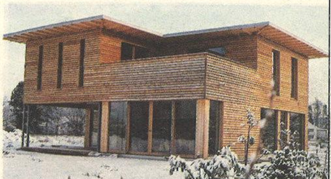
Bauherr: Karin u. Christian Strasser, Dornbirn Planung: MM3 Simma-Rümmele, Dornbirn Holzbaubetrieb: Zimmerei Helmut Feuerstein, Au
