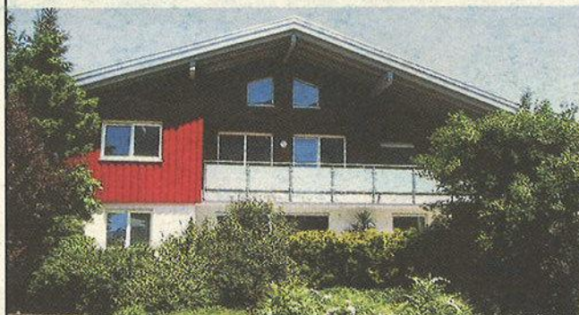
Bauherr: Wolfgang Lässer, Schlins Planung: Fridl Madlener, Schlins Holzbaubetrieb: Zimmerei Thomas Berchtel, Schnifis
