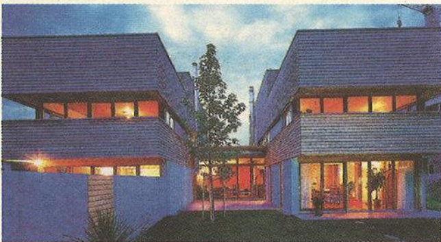
Bauherr: K. Haselwander u. H. Martini, Lauterach Planung: Kurt Schuster, Dornbirn Holzbaubetrieb: Berlinger Holzbau GmbH, Alberschwende
