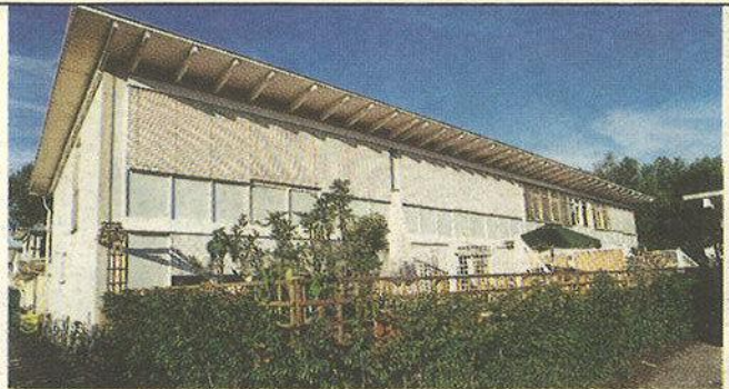
Bauherr: Vogewosi, Dornbirn Planung: Markus Koch, Altach Holzbaubetrieb: Holzbau Kaspar Greber GmbH, Bezaú
