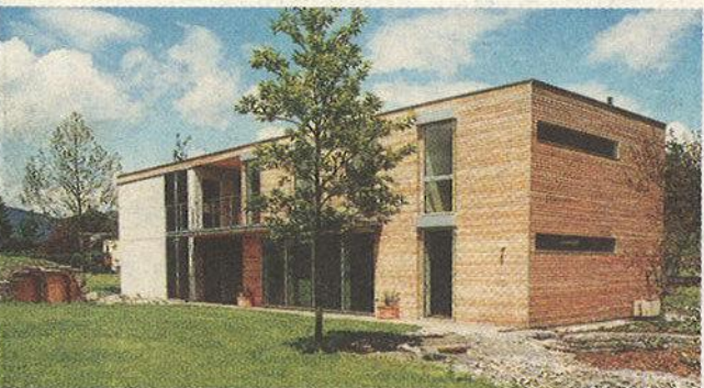
Bauherr: Anton Gächter, Koblach Planung: Bernd Federspiel, Feldkirch Holzbaubetrieb: Chr. Walch, VlbG. Ökohaus GmbH, Ludesch
