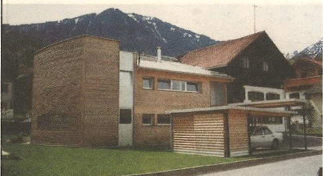
Bauherr: Elke und Günter Zerlauth, Nenzing Planung: Eckart Kern, Innsbruck Holzbaubetrieb: Zimmerei August Neyer GmbH, Bludenz
