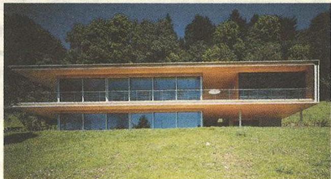
Bauherr: Reinhard Fuchs, Langen bei Bregenz Planung: Hermann Kaufmann, Schwarzach Holzbaubetrieb: Berchtold N. GmbH & Co. KG, Wolfurt
