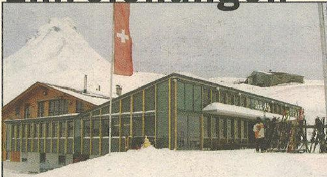
Bauherr: Ivo Bertsch, Damüls Planung: Johann Muxel, Au Holzbaubetrieb: Fetz Holzbau GmbH, Egg
