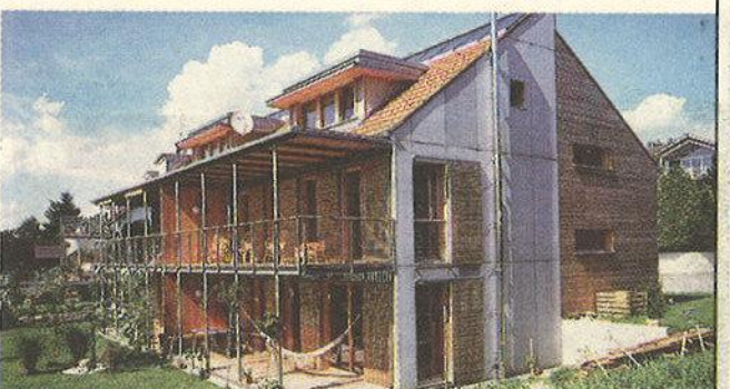
Bauherr: Sabine Eber u. Thomas Freytag, Lindau (D) Planung: Erber Architekten, Lindau (D) Holzbaubetrieb: Berchtold N. GmbH & Co. KG, Wolfurt
