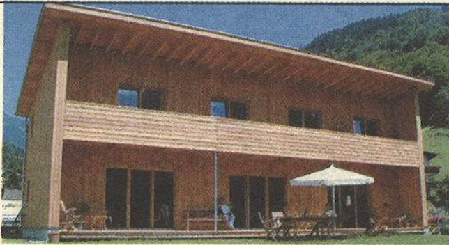
Bauherr: Bernhard und Sonja Kieber, Schruns Planung: Vonier/Haumer, Schruns Holzbaubetrieb: Kieber Holzbau GmbH, Schruns
