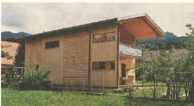
Bauherr: Veronika und Kilian Tschabrun, Muntlix Planung: Kilian Tschabrun, Rankweil Holzbaubetrieb: Zimmerei Helmut Feuerstein, Au
