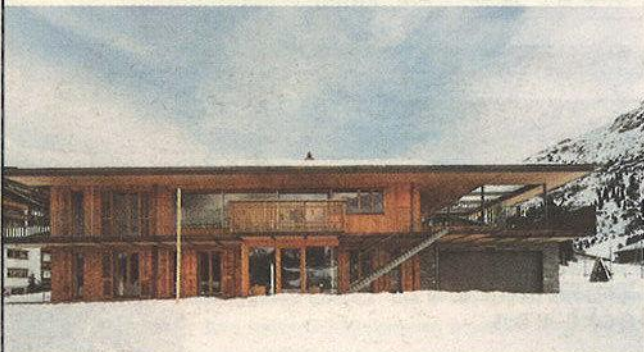
Bauherr: Diana und Ludwig Muxel, Lech Planung: Atelier Rainer & Amann, Feldkirch Holzbaubetrieb: Kieber Holzbau GmbH, Schruns
