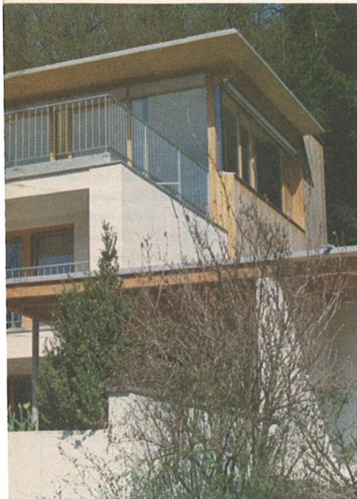
gangszeit auch eine teilweise Heizfunktion. Die Hauptwärmequelle ist aber eine Ölzentralheizung mit Brennwertkessel. Das Dach ist aus verleimten Holzbalken gefertigt, die Fußböden aus Douglas-Riemern, die Wände sind Holzriegelwerk, die Stiegen sind ebenfalls aus Douglas-Holz.
