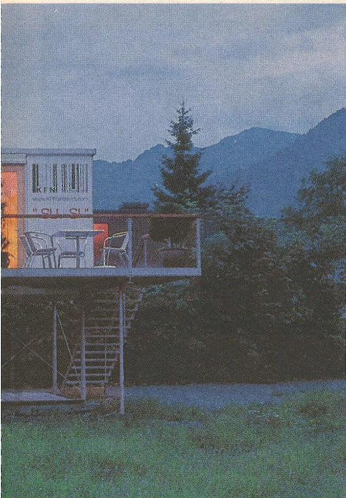
Stunden bezugsfertig. Das Instantheus wird vom Kranwagen auf ein Fundament oder Stützen gehievt und muss nur noch an die Strom- und Wasserleitungen angeschlossen werden. Die Holzkiste selbst kann in drei Wochen gefertigt werden, inklusive Fassaden, Dach, Verglasungen, Bad und Küche.
