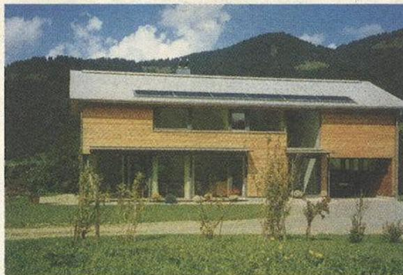
Das Holzhaus in Elementbauweise verfügt über eine hohe wärmegeämmte Wandkonstruktion. Der Rahmen wurde lediglich halb vorgefertigt, um den Bauherrn mehr Eigenleistung zu ermöglichen. Die Außenwände sind innen mit doppelter Gipskartonbeplankung geschlossen und mit Zellulosefasern ausgeblasen. Die Außenfassade trägt eine naturbelassene Lärchenstülpeschalung – eine Alternative zur traditionellen Schindelfassade.
