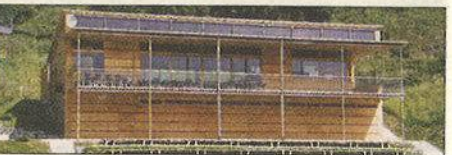
Bauherr: Gemeinde Bizau, Bizau Planung: D.I. Hermann Kaufmann, Schwarzach Ausführung: Kaufmann Holzbauwerk, Reuthe
