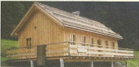
Bauherr: Gemeinde Klösterle Planung: Thomas Heim, Thüringen Ausführung: August Neyer GmbH, Bludenz
