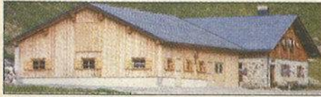
Bauherr: Alpe Spullers, Braz Planung: Agrarbezirksbehörde, Landhaus Bregenz Ausführung: August Neyer GmbH, Bludenz
