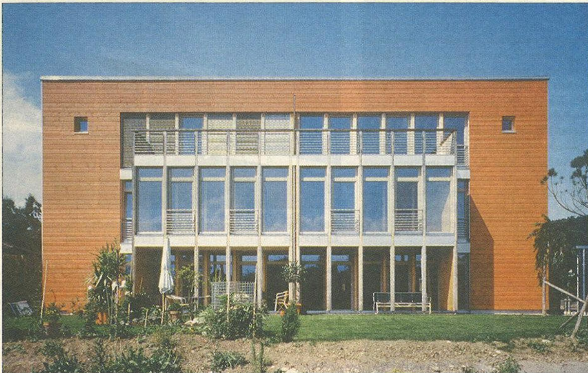
Äußere Bretterverkleidung legt sich als orange Schale über die Ständerkonstruktion.
