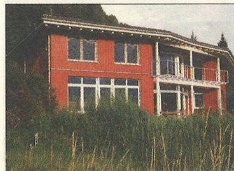
Bauherr: M. & O. Kriszeleit, Nüziders Planung: M. & O. Kriszeleit, Nüziders Ausführung: Wucher Holzbau GmbH, Ludesch
