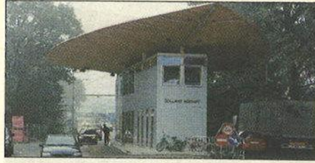
Bauherr: Landeshochbauamt, Feldkirch Planung: Arch. Martin Häusle, Feldkirch Ausführung: I+R Schertler, Lauterach
