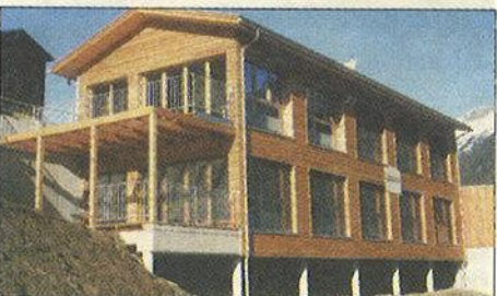
Bauherr: Reinhard Zehetner, Kennelbach Planung: D.I. Oskar Ganahl, Schruns Ausführung: Wucher Holzbau GmbH, Ludesch
