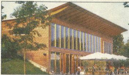
Bauherr: Gemeindeamt Höchst, Höchst Planung: D.I. G. Gassner, Höchst Ausführung: Zimmerei H. Hartmann, Hard
