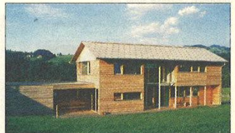
Bauherr: Karl Heinz Rusch, Alberschwende Planung: Ing. Gerold Leuprecht, Dornbirn Ausführung: Berchtold Holzbau, Wolfurt
