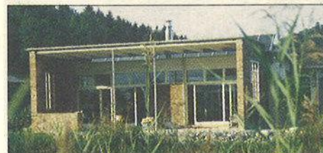
Bauherr: J. & R. König, Frastanz Planung: Wilfried Gassner, Eschen Ausführung: Berchtold Holzbau, Wolfurt
