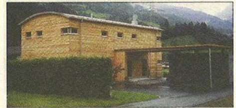
Bauherr: Pernull/Ganahl, Tschagguns Planung: Arch. Christian Vonier, Schruns Ausführung: Fritz Holzbau, St. Anton i. Montafon
