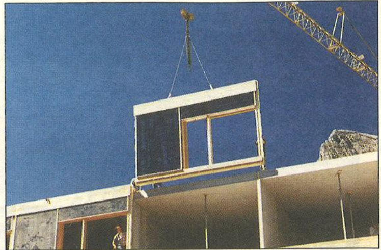
Hotel Adler, Hochkrumbach. Einbau von fassadenintegrierten Sonnenkollektoren.
