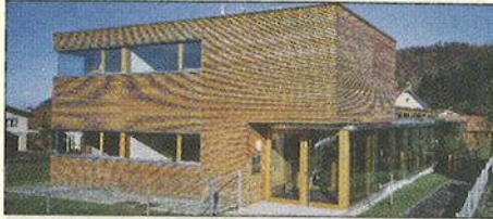
Bauherr: Gemeinde Schwarzach, Schwarzach Planung: Dietrich/Untertrifaller, Bregenz Ausführung: Helmut Böhler, Wolfurt
