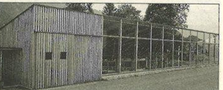
Bauherr: Probstei St. Gerold, St. Gerold Planung: D.I. Hermann Kaufmann, Schwarzach Ausführung: Wucher Holzbau, Ludesch
