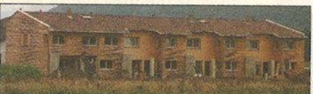
Bauherr: Fam. Vonier, Ludesch Planung: August Neyer GmbH, Bludenz Ausführung: August Neyer GmbH, Bludenz
