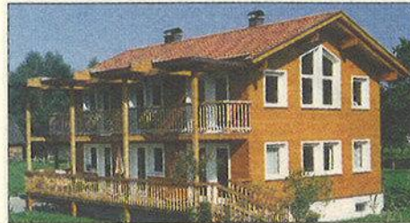
Bauherr: Christine Zucol-Martin, Fußsach Planung: Christine Zucol-Martin, Fußsach Ausführung: Holzbau Sohm, Alberschwende
