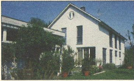
Bauherr: W. & I. Spiegel, Lustenau Planung: D.I. Hermann Gort, Frastanz Ausführung: Wucher Holzbau GmbH, Ludesch
