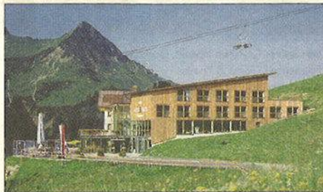
Bauherr: Bertram Bischof, Damüls Planung: D.I. Leopold Kaufmann, Dornbirn Ausführung: Gebrüder Heiseler, Sonntag
