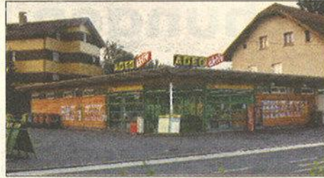
Bauherr: ADEG, Gaudenzdorfergürtel 41, Wien Planung: D.I. Hermann Kaufmann, Schwarzach Ausführung: Berchtold Holzbau, Wolfurt
