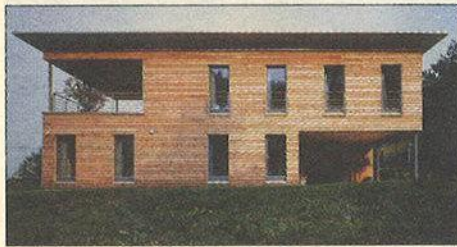
Bauherr: A. & J. Salzgeber, Dornbirn Planung: D.I. Dieter Groß, Dornbirn Ausführung: Fritz Holzbau, Montafon
