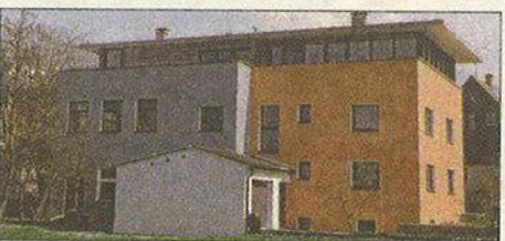
Bauherr: B. & M. Schwendinger, Dornbirn Planung: Arch. Raimund Wulz, Telfs Ausführung: Kaufmann Holzbauwerk, Reuthe
