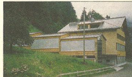
Bauherr: Gemeinde Sonntag Planung: D.I. Gernot Thurnher, Feldkirch Ausführung: Sutter Holzbau, Ludesch
