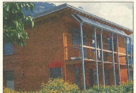
Bauherr: T. & S. Vonbank, Bürs Planung: Wolfgang Bickel, Nüziders Ausführung: August Neyer GmbH, Bludenz
