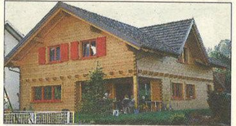
Bauherr: Lins und Johanna Arthur, Frastanz Planung: Gebr. Heiseler GmbH, Sonntag Ausführung: Gebr. Heiseler GmbH, Sonntag
