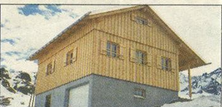
Bauherr: Deutscher Alpenverein, Heilbronn Planung: D.I. Stehle + Ruppert, Heilbronn Ausführung: August Neyer GmbH, Bludenz
