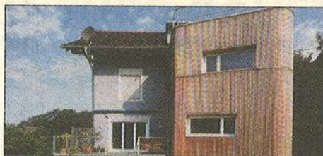
Bauherr: Christian Häusle, Dornbirn Planung: Gohm & Hiesberger, Feldkirch Ausführung: Fussenegger & Rümmele, Dornbirn
