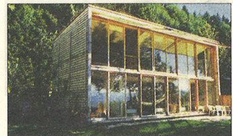
Bauherr: Hanspeter Sonnlichler, Lochau Planung: Arch. Markus Thurnher, Bregenz Ausführung: Kaspar Greber, Bezau
