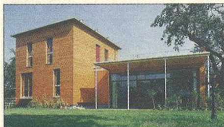
Bauherr: Wolfgang Bargehr, Sulz Planung: Hans-Peter Lang, Göfis Ausführung: Holzbau Sohm, Alberschwende
