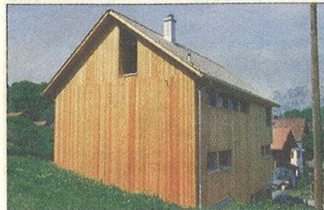
Bauherr: Hassler-Röthlisberger, Schellenberg Planung: D.I. Florin Frick, Schaan Ausführung: Holzbau Lot GmbH, Feldkirch-Nofels
