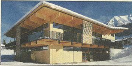
Bauherr: Gemeinde Mittelberg, Riezlern Planung: Oksakowski+Schaffer, Feldkirch Ausführung: Kaufmann Holzbauwerk, Reuthe
