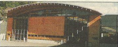
Bauherr: Stadt Dornbirn, Dornbirn Planung: Arch. L. Kaufmann, Dornbirn Ausführung: Fussenegger & Rümmele, Dornbirn
