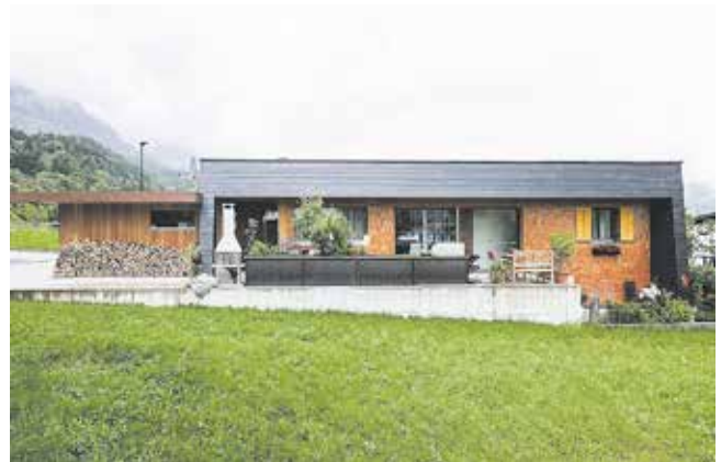
Objekt EFH Zech, Nenzing Bauherr Barbara und Stefan Zech, Nenzing Planung Johnny Tiefenthaler, Schlins Holzbau Dobler Holzbau GmbH, Rötthis
