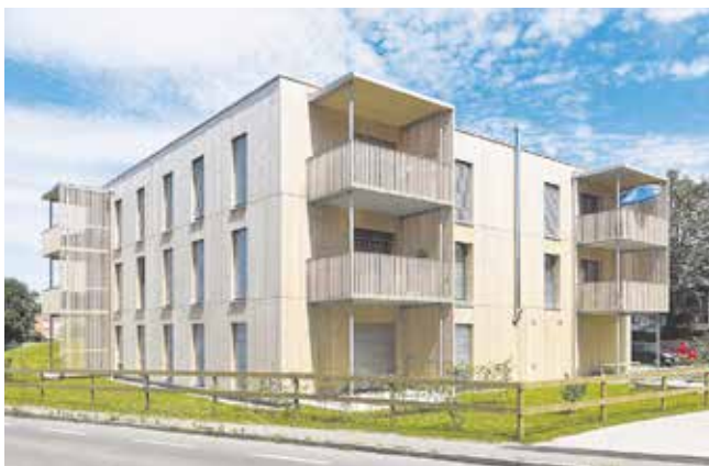
Objekt MFH WOHNEN500+ Kastenlangen, Dornbirn Bauherr VOGEWOSI VlbG. gemeinnützige Wohnungsbau- und Siedlungs GmbH, Dornbirn Planung Johannes Kaufmann Architektur, Dornbirn Holzbau Kaufmann Bausysteme GmbH, Reuthe
