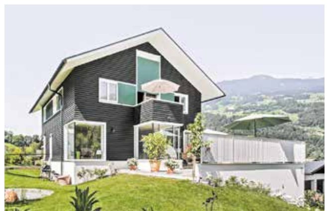
Objekt Haus F Bauherr Anonym Planung LRO Lederer Ragnarsdóttir Oei GmbH & Co. KG, Stuttgart Holzbau Holzbau Feuerstein GmbH & Co. KG, Au
