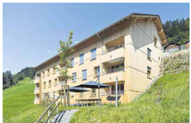
Objekt MFH Bühl, Sonntag Bauherr WSH Wohnbauselbsthilfe Vorarlberg gem. reg. GenmbH, Bregenz Planung Johannes Kaufmann Architektur, Dornbirn Holzbau Zimmerei Heiseler GmbH & Co KG, Sonntag
