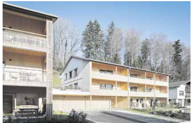
Objekt MFH Bruggan, Egg Bauherr Fetz Immobilien GmbH, Egg Planung Johannes Kaufmann Architektur, Dornbirn Holzbau Fetz Holzbau GmbH, Egg
