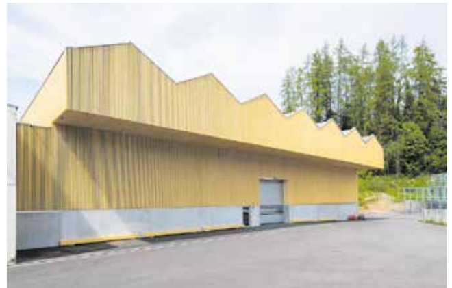
Objekt Lagerhalle FRIES Kunststofftechnik, Sulz Bauherr FRIES Kunststofftechnik GmbH, Sulz Planung reitbruggerGAU ZT OG, Bregenz Holzbau Sohm HolzBautechnik GmbH, Alberschwende
