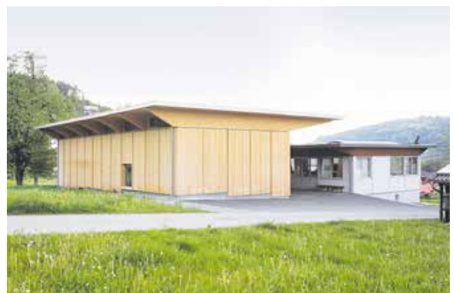
Objekt Betriebserweiterung Tischlerei Jussel, Nenzing Bauherr Markus und Lukas Jussel, Nenzing Planung Magdalena Rauch Holzbau Dobler Holzbau GmbH, Röthis
