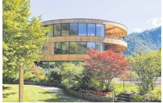
Objekt Aufstockung Badehaus Bad Reuthe Bauherr Bad Reuthe Frick GmbH, Reuthe Planung Frick Architekt ZT GmbH, Reuthe Holzbau Berchtold Gerhard, Zimmerei - Treppenbau, Schwarzenberg
