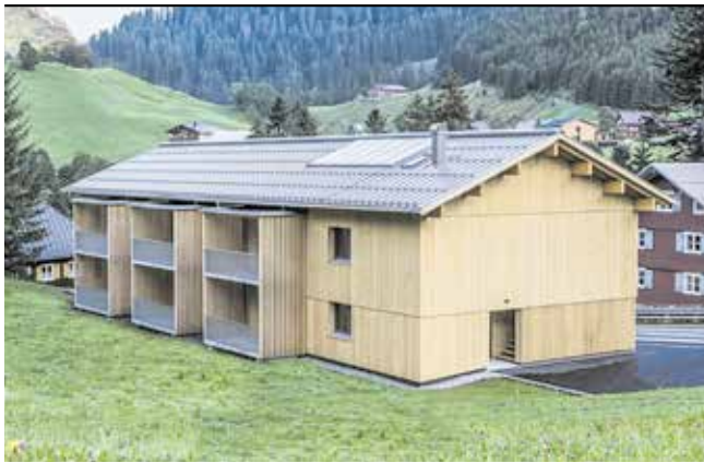
Objekt MFH WOHNEN500+ Stutz, Schröcken Bauherr VOGEWOSI VlbG. gemeinnützige Wohnungsbau- und Siedlungs GmbH, Dornbirn Planung Johannes Kaufmann Architektur, Dornbirn Holzbau Kaufmann Bausysteme GmbH, Reuthe
