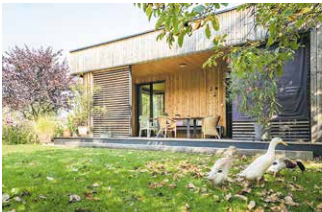
Objekt Gartenwohnung, Feldkirch Bauherr Werner Allgäuer und Angelika Nußbaumer, Feldkirch Planung Helmut Taudes, Nüziders Holzbau Alfred Feuerstein GmbH & Co KG, Bludenz
