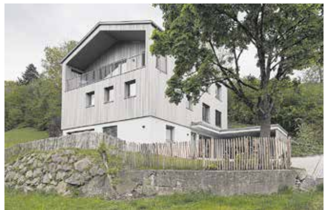
Objekt Zweifamilienhaus am Hang Bauherr Anonym Planung Catharina Fineder Architektur, Feldkirch Holzbau Sutter Holzbau GmbH, Ludesch
