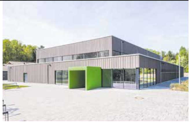
Objekt Neubau Sporthalle, Moos (D) Bauherr Gemeinde Moos Planung Dury + D'Aloisio Architekten BDA, Konstanz Holzbau i+R Holzbau GmbH, Lauterach
