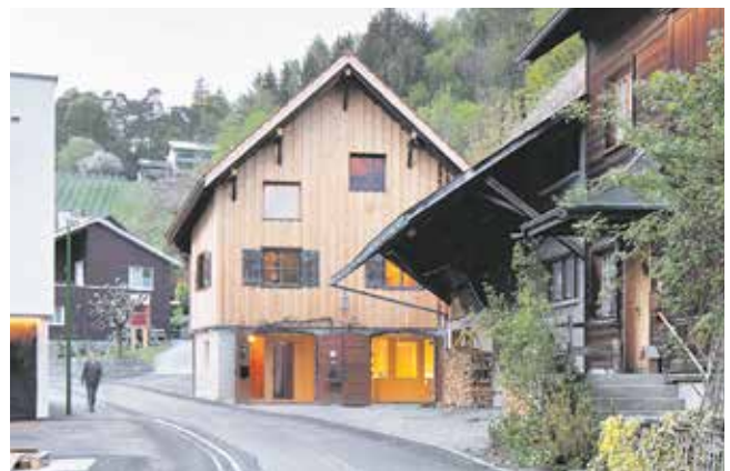
Objekt Torkel, Röthis Bauherr Petra und Thomas Feurstein, Röthis Planung Julia Kick Architekten, Dornbirn Holzbau Gebrüder Keckeis GmbH, Lustenau
