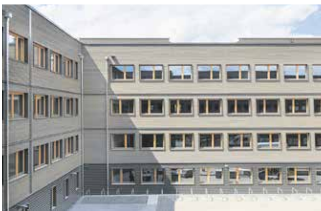
Objekt Oberschule Am Barnet-Licht-Platz, Leipzig Bauherr Stadt Leipzig Planung Kaden+Lager, Berlin Holzbau Kaufmann Bausysteme GmbH, Reuthe
