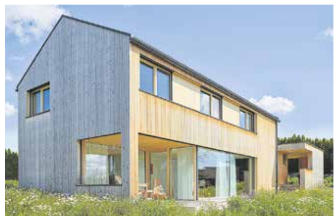
Objekt EFH M, Zezikon (CH) Bauherr Silvan Mazenauer und Melanie Peer, Zezikon Planung Architektur Jürgen Hagspiel, Lingenau Holzbau Alpina Hausbau GmbH, Hard
