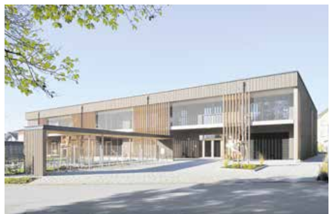
Objekt Neubau Kindertagesstätte, Markdorf (D) Bauherr Stadt Markdorf Planung D'Aloisio Architekten BDA, Konstanz Holzbau i+R Holzbau GmbH, Lauterach
