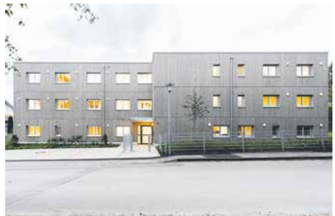
Objekt Ausweichbau Wilhelmsdorf (D) Bauherr Die Ziegler'schen e. V., Wilhelmsdorf Planung Gross Architekten GmbH, Wilhelmsdorf Holzbau oa.sys baut gmbh, Alberschwende
