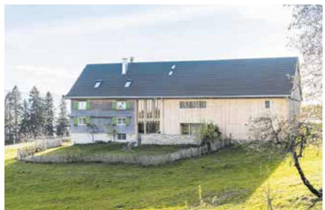
Objekt EFH G & B, Sulzberg Bauherr Prof. Dr. Gantner Florian, Ermatingen Planung Hermann Kaufmann + Partner ZT GmbH, Schwarzach Holzbau Bestand: Zimmerei Gerhard Bilgeri GmbH, Riefensberg Holzbau Umbau: Fetz Holzbau GmbH, Egg
