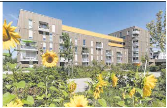
Objekt MFH Wagnis, München (D) Bauherr Wohnbaugenossenschaft Wagnis eG, München Planung Zwischenräume Architekten + Stadtplaner GmbH, München Holzbau oa.sys baut gmbh, Alberschwende
