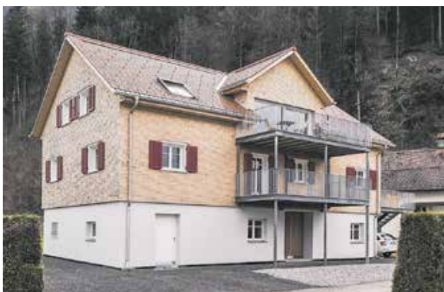
Objekt MFH Gächter, Hohenems Bauherr Gerhard Gächter, Hohenems Planung Planungsbüro BM Ing. Herbert Mathis, Hohenems Holzbau Berchtold Gerhard, Zimmerei - Treppenbau, Schwarzenberg
