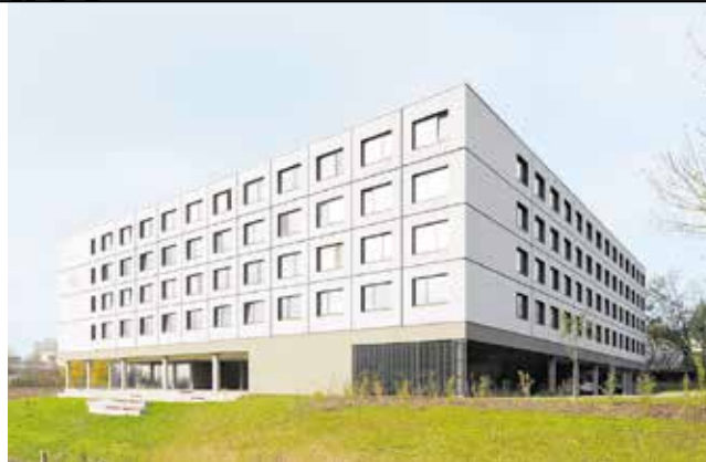
Objekt Studentenwohnheim Lutterterrasse, Göttingen (D) Bauherr Studentenwerk Göttingen Planung LIMA Architekten, Stuttgart Holzbau Kaufmann Bausysteme GmbH, Reuthe
