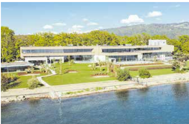
Objekt Therme Lindau Bauherr Therme Lindau GmbH, Schauer & Co GmbH, Überlingen Planung 4a Architekten GmbH, Stuttgart Holzbau oa.sys baut gmbh, Alberschwende
