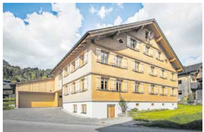
Objekt „Geabata-Michla-Hus“ Bauherr + Planung Martin Berbig, Au Idee, Entwurf, Gestaltung Dipl.-Ing. Arch. Thomas Mennel und Dipl.-Ing. Arch. Helmut Batlogg Holzbau Holzbau Feuerstein GmbH & Co. KG, Au
