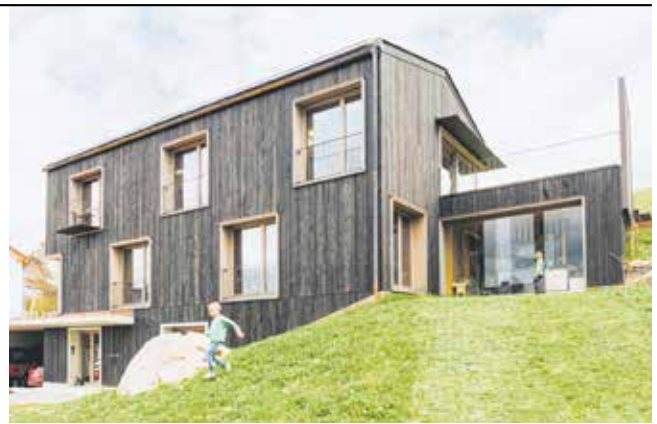
Objekt Einfamilienhaus mit Bürofläche, Scheidegg (CH) Bauherr Christine Mayr-Baldauf und Oliver Baldauf, Scheidegg Planung mayr-baldauf architektur und stadtgestaltung, Lindenberg im Allgäu Holzbau Fetz Holzbau GmbH, Egg
