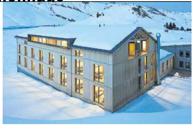
Objekt Mitarbeiterhaus Salober, Schröcken Bauherr Skilifte Schröcken Strolz GmbH, Schröcken Planung Johannes Kaufmann Architektur, Dornbirn Holzbau kaufmann zimmerei u. tischlerei gmbh, Reuthe
