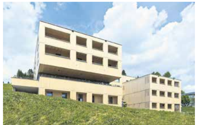
Objekt JUFA Hotel "Klangholzhuis", Laterns Bauherr JUFA Hotels Österreich GmbH, Graz Planung Johannes Kaufmann Architektur, Dornbirn Holzbau Franz Lederer-Grabner Baugesellschaft mbH, Graz
