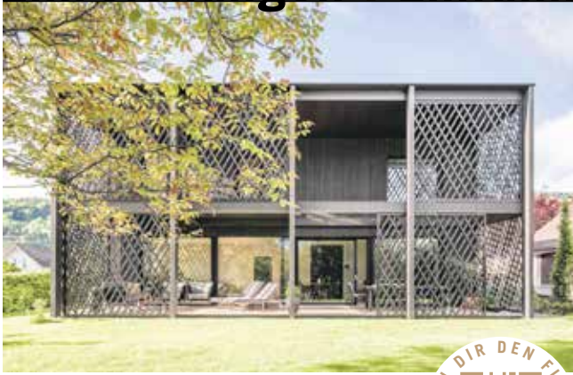
Objekt Wohnen im Garten Bauherr Anonym Planung querschnitt architekten zt gmbh, Wolfurt Holzbau Kaspar Greber Holz- u. Wohnbau GmbH, Bezau
