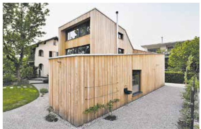
Objekt EFH Kohler Bauherr Anonym Planung albrecht-bereiter-architekten, Dornbirn Holzbau Zimmerei JOSO GmbH, Alberschwende
