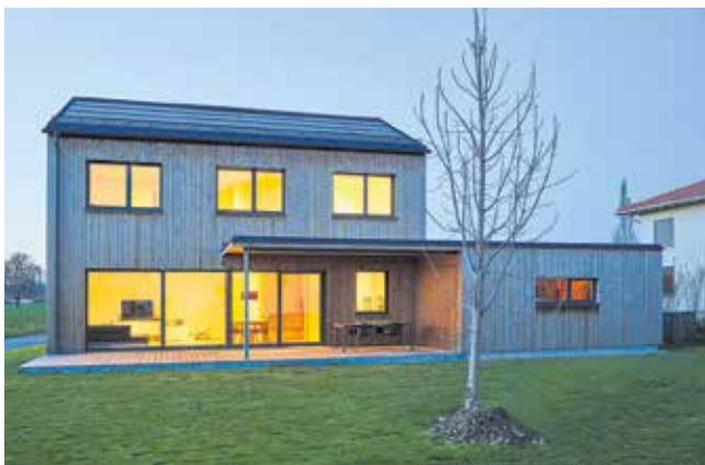
Objekt EFH SU Bauherr Anonym Planung DI Hebein Udo, Wolfurt Holzbau Berchtold Holzbau GmbH & Co. KG, Wolfurt
