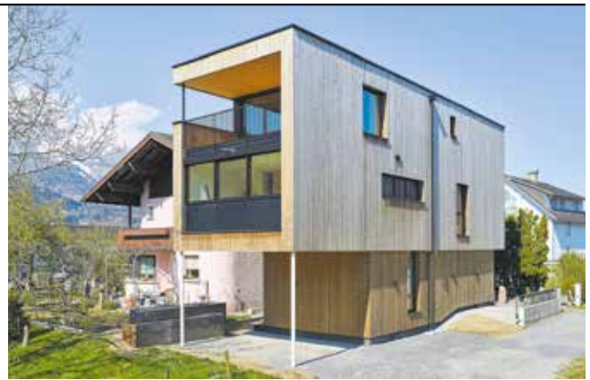
Objekt Aufstockung K Bauherr Anonym Planung DI Hebein Udo, Wolfurt Holzbau Berchtold Holzbau GmbH & Co. KG, Wolfurt
