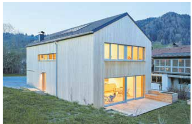
Objekt EFH ST Bauherr Anonym Planung Hermann Kaufmann + Partner - Andreas Ströhle, Schwarzach Holzbau Berchtold Holzbau GmbH & Co. KG, Wolfurt
