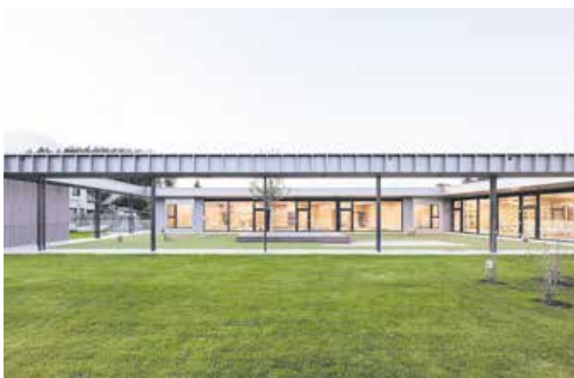
Objekt Kindergarten Kinderkrippe Mühlgasse: Ein „Nest“ für Kinder, Lannach Bauherr Marktgemeinde Lannach Planung Bertold Weber Architekten ZT GmbH, Dornbirn Holzbau Holzbau Fürnussch GmbH, Freidorf an der Laßnitz
