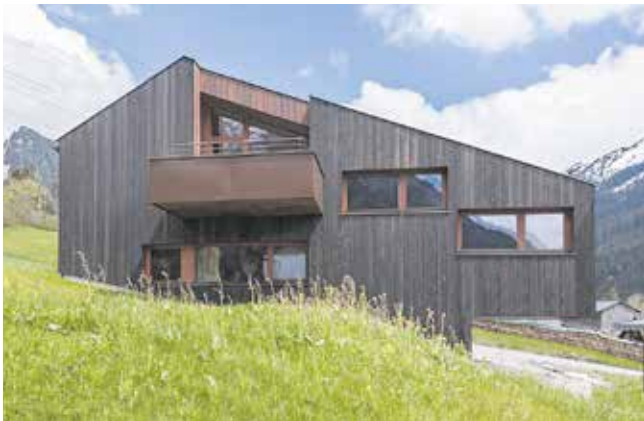
Objekt EFH mit Split Level, Wald am Arlberg Bauherr Sandra Köbler und Markus Gitterle, Wald am Arlberg Planung Atelier Ender | Architektur OG, Nüziders Holzbau Neyer Holzbau GmbH, Bludenz
