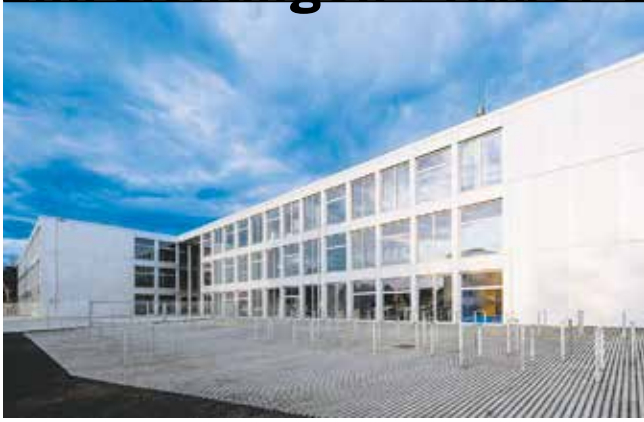
Objekt Integrierte Sekundarschule Mahlsdorf, Berlin Bauherr Senatsverwaltung für Stadtentwicklung und Umwelt, Abteilung V, Hochbau, Berlin Planung NKBAK Architekten, Frankfurt Holzbau Kaufmann Bausysteme GmbH, Reuthe
