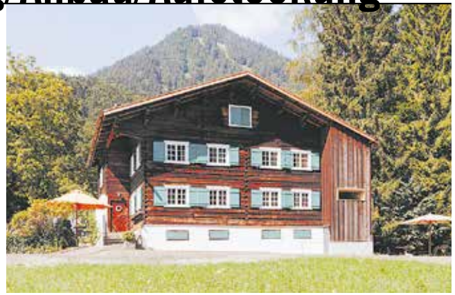
Objekt Ferienhaus Benedikta, Vandans Bauherr Dr. Elisabeth Brändle, Vandans Planung architektur.terminal hackt und klammer, Röthis Holzbau Zimmerei Mathies, St. Gallenkirch
