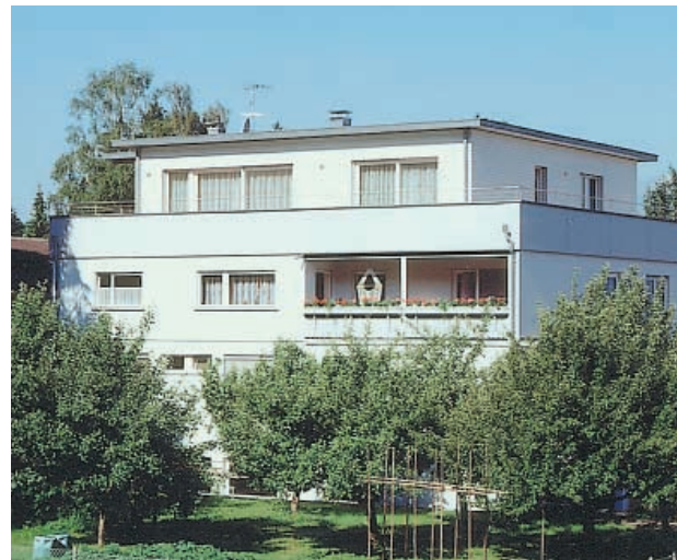
Bauherr: Helmut Huber, Muntlix Planung: Wolfgang Kopf WWK Bauorganisation GmbH, Muntlix Holzbaubetrieb: Dobler Bau GmbH, Röthis
