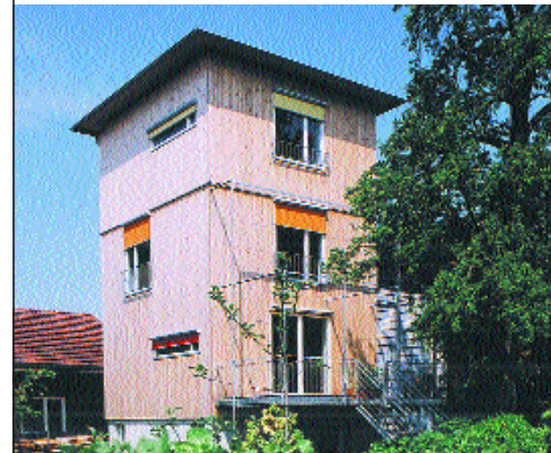
Bauherr: Thurnher Thomas und Carina, Dornbirn Planung: Bauwerkstatt Elisabeth Rüdiger, Hohenems Holzbaubetrieb: LOT Holzbau GmbH, Feldkirch
