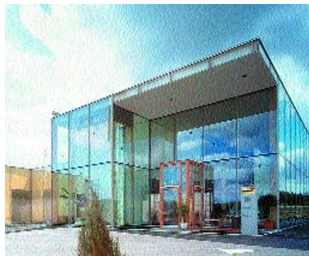
Bauherr: Fa. Schlossgangl, Steyr Planung: DI Walter Unterrainer, Feldkirch Holzbaubetrieb: Berlinger Holzbau GmbH, Alberschwende
