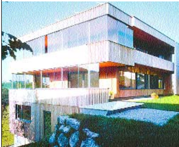
Bauherr: Thomas Sohm, Alberschwende Planung: DI Christian Lenz, Schwarzach Holzbaubetrieb: Sohm Holzbautechnik GmbH, Alberschwende
