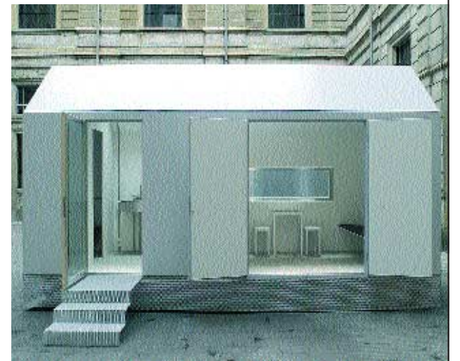
Bauherr: Berlinger Holzbau, Alberschwende Planung: DI Oskar Leo Kaufmann, Dornbirn Holzbaubetrieb: Berlinger Holzbau GmbH, Alberschwende
