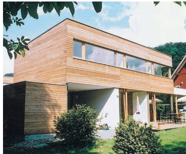
Bauherr: Kleinbrod Hanno und Wolfgang, Dornbirn Planung: BM Hagspiel Jürgen, Lingenau Holzbaubetrieb: Alpina Bau- und Holzelemente GmbH, Hard
