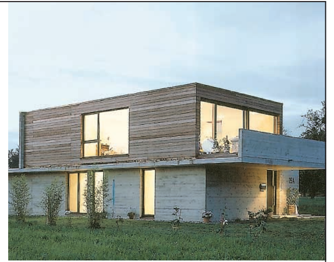
Bauherr: Angela Ganthaler, Gaißau Planung: Architekturbüro Früh, Hard Holzbaubetrieb: Feuerstein Zimmerei · Tischlerei · Treppenbau, Au
