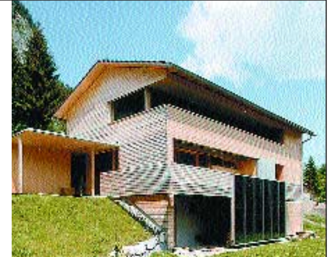
Bauherr: Thomas Peter, Dornbirn Planung: Ing. Gerold Leuprecht, Dornbirn Holzbaubetrieb: Rheinhaus Holzbau GmbH & Co, Dornbirn
