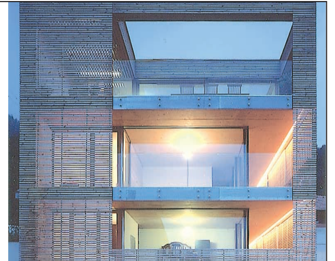
Bauherr: Marianne und Michael Fritz, Bregenz Planung: Raum für Architektur, Dornbirn Holzbaubetrieb: Meusburger Holzbau, Lauterach
