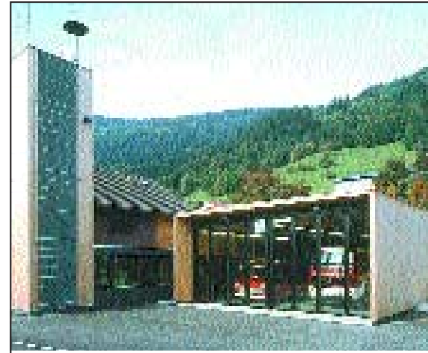
Bauherr: Gemeinde Düns, Düns Planung: DI Wolfgang Ritsch, Dornbirn Holzbaubetrieb: Berchtel GmbH, Zimmerei, Schnifis
