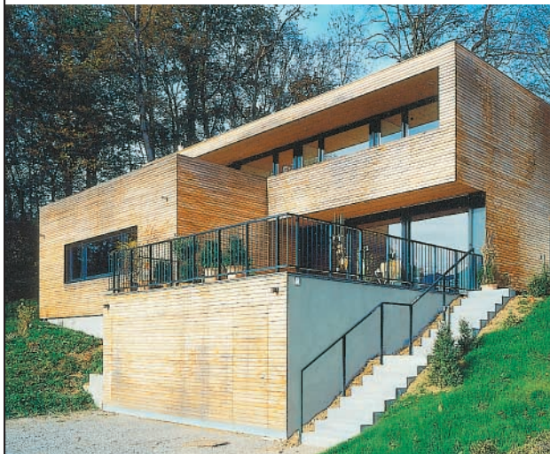
Bauherr: Cornelia und Gebhard Lutz, Schllins Planung: DI Gebhard Lutz, Schllins Holzbaubetrieb: Dobler Bau GmbH, Röthis
