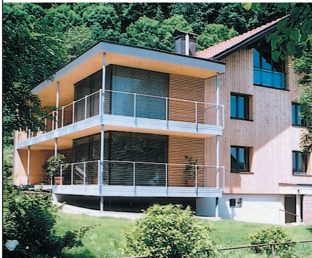
Bauherr: Vollweiter Werner und Elisabeth, Langen Planung: BM Hagspiel Jürgen, Lingenau Holzbaubetrieb: Alpina Bau- und Holzelemente GmbH, Hard
