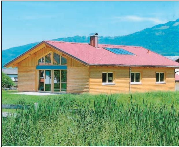
Bauherr: Hans Steiner, Nenzing Planung: Fa. Ammannbau, Nenzing Holzbaubetrieb: Zimmerei Berchtel GmbH, Schnifis
