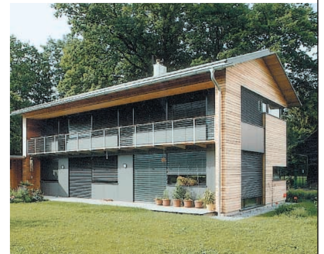
Bauherr: Dr. Roland und Brigitte Maier-Ellsensohn, Feldkirch-Nofels Planung: Ing. Gerold Leuprecht, Dornbirn Holzbaubetrieb: Berchtold N. GmbH & Co KG, Wolfurt
