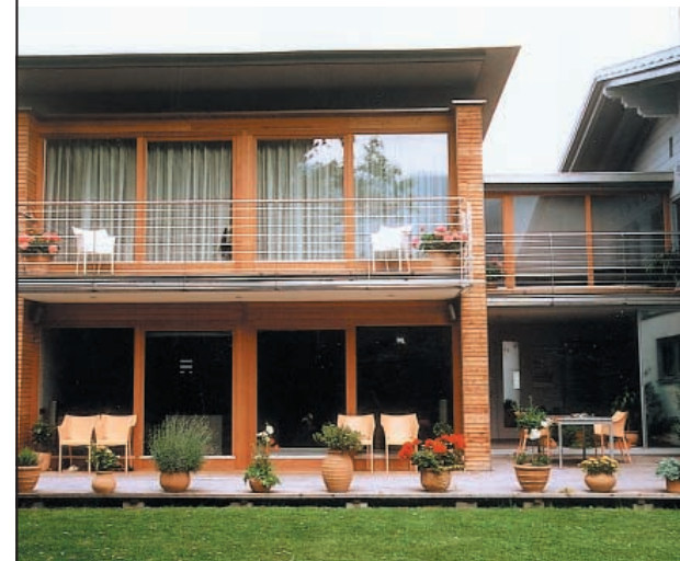
Bauherr: Sparr Christoph + Anita, Ludesch Planung: Heim + Müller arch. GmbH, Dornbirn Holzbaubetrieb: Wucher Holzbau GmbH & Co KG, Ludesch
