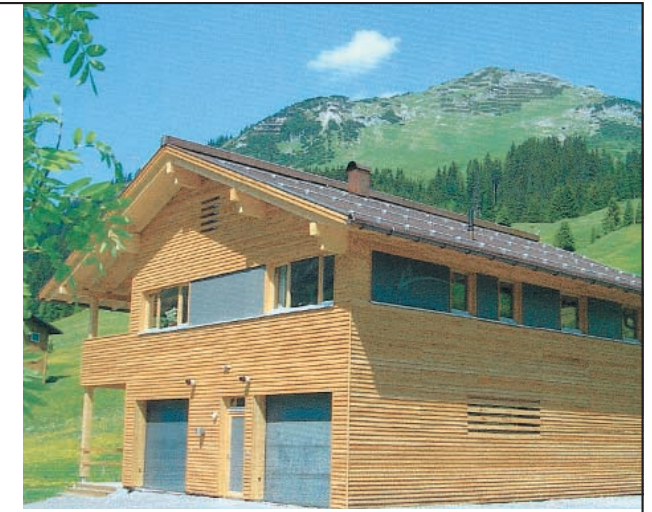
Bauherr: Schilifte Lech Ing. Bildstein GmbH, Lech Planung: Tangens Projects H. Kutzer, Au CH Holzbaubetrieb: Feuerstein Zimmerei · Tischlerei · Treppenbau, Au
