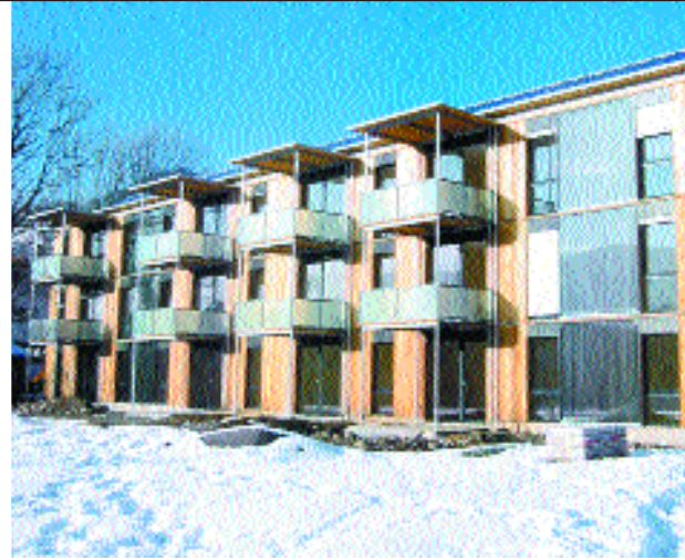
Bauherr: Vbg. Gemeinnützige Wohnbau- u. Siedlungs GmbH, Dornbirn Planung: DI Hermann Kaufmann, Schwarzach Holzbaubetrieb: Fritz Holzbau, Schruns
