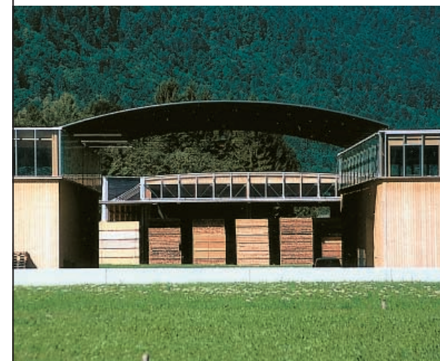
Bauherr: Wäderhaus Bezau Planung: DI Hermann Kaufmann, Schwarzach Holzbaubetrieb: ARGE Sohm/Berlinger/Berchtold W.
