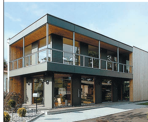
Bauherr: TBM_Techn.- Büro für Maschinenbau, Ing. Harry Geher, Höchst Planung: Ing. Gerold Leuprecht, Dornbirn Holzbaubetrieb: Berchtold N. GmbH & Co KG, Wolfurt
