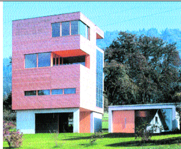
Bauherr: Heidemarie Hofbauer, Hörbranz Planung: k_m Architektur, Bregenz Holzbaubetrieb: Böhler H. Holzbau GmbH, Wolfurt
