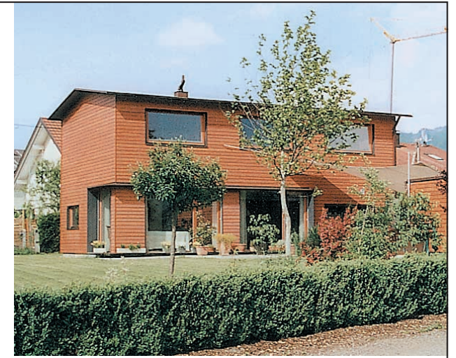
Bauherr: Vigl Cornelia und Rene, Rankweil Planung: Helmut Brunner, Bregenz Holzbaubetrieb: LOT Holzbau GmbH, Feldkirch
