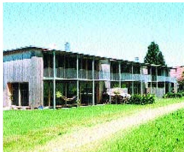
Bauherr: Alpina Bau- und Holzelemente GmbH – Margreiter Marco, Hard Planung: BM Hagspiel Jürgen, Lingenau Holzbaubetrieb: Alpina Bau- und Holzelemente GmbH, Hard
