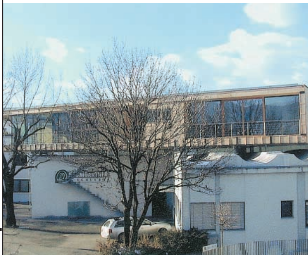
Bauherr: Tischlerei Baumgartner, Bruneck, Südtirol Planung: Dr. Arch. Micheli Marco, Bruneck, Südtirol Holzbaubetrieb: Berchtold N. GmbH & Co KG, Wolfurt
