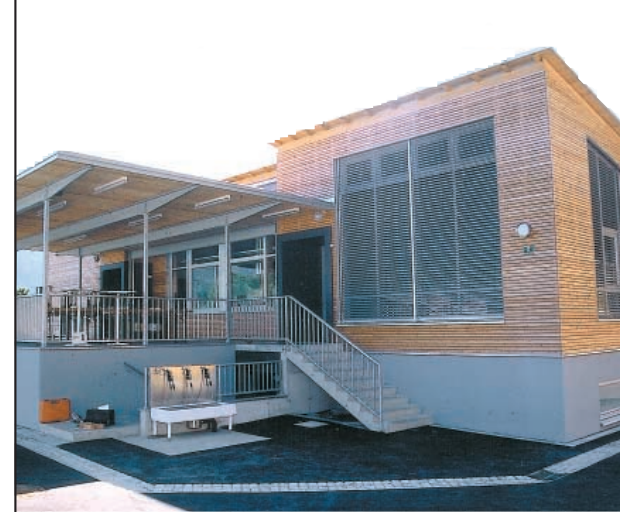
Bauherr: Gemeinde Bürs, Bürs Planung: Gruppo Sportivo, Bludenz Holzbaubetrieb: Wucher Holzbau GmbH & Co KG, Ludesch
