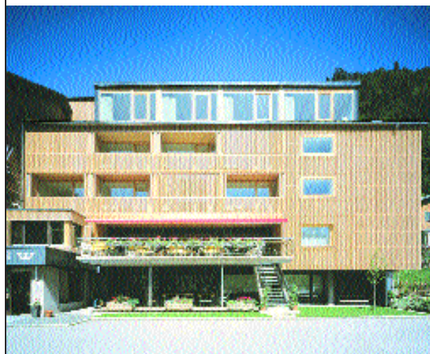
Bauherr: Hotel Krone, Walter Lingg KG, Au Planung: DI Oskar Leo Kaufmann, Dornbirn Holzbaubetrieb: Feuerstein Zimmerei-Tischlerei-Treppenbau, Au
