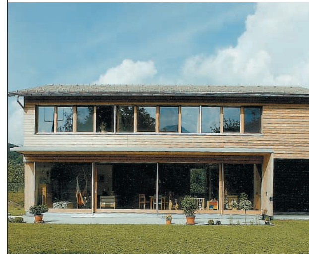
Bauherr: Hofherr Michael und Klaus, Frastanz Planung: DI Hermann Kaufmann, Schwarzach Holzbaubetrieb: Berchtold N. GmbH & Co KG, Wolfurt
