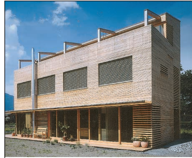
Bauherr: Norman und Margit Walch, Ruggell Planung: Hartl Leitgeb eba Architekten, Wien Holzbaubetrieb: Holzbau Fetz GmbH, Egg
