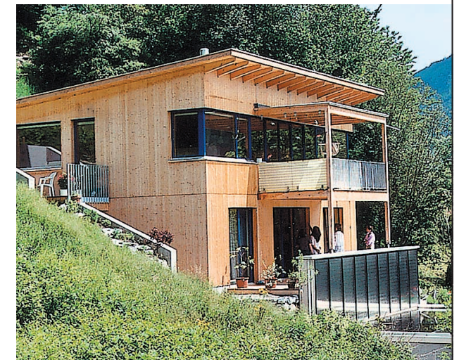
Bauherr: Kötter Hedwig, Wens Planung: Zmst. Kilian Tschabrunn, Muntlix Holzbaubetrieb: Dobler Bau GmbH, Rötthis
