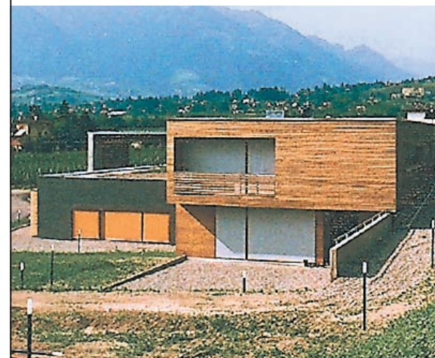
Bauherr: Autonome Provinz Bozen, Bozen Planung: Dr. arch. Peter Plattner, Bozen Holzbaubetrieb: Berlinger Holzbau GmbH, Alberschwende
