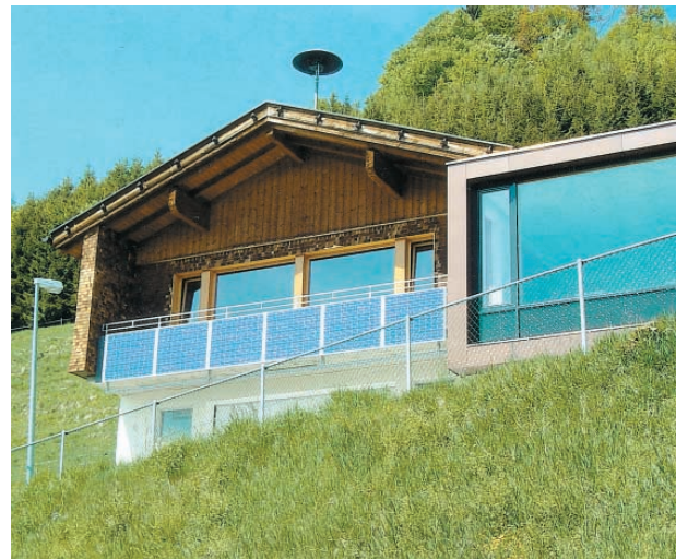
Bauherr: Gemeine Dünserberg, Dünserberg Planung: Berger + Raggl GmbH, Röns Holzbaubetrieb: Berchtel GmbH, Zimmerei, Schnifis
