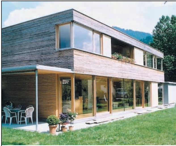
Bauherr: Hörburger Ingo und Andrea, Dornbirn Planung: BM Hagspiel Jürgen, Lingenau Holzbaubetrieb: Alpina Bau- und Holzelemente GmbH, Hard
