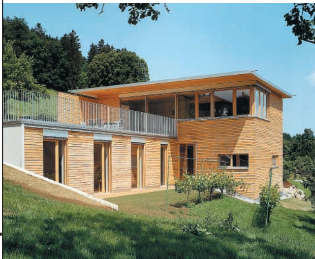
Bauherr: DI Siegbert und Birgit Terzer, Göfis Planung: DI Johannes Nägele/Hans Nägele, Göfis Holzbaubetrieb: Jürgen Nesensohn, Zimmerei, Rankweil
