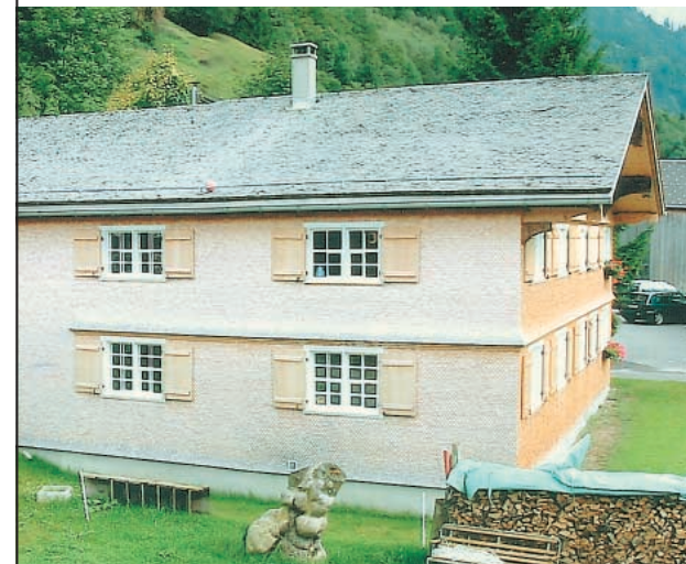
Bauherr: Matt Jochen und Carmen, Schoppertau Planung: DI Felder Walter, Dornbirn Holzbaubetrieb: Feuerstein Zimmerei · Tischlerei · Treppenbau, Au
