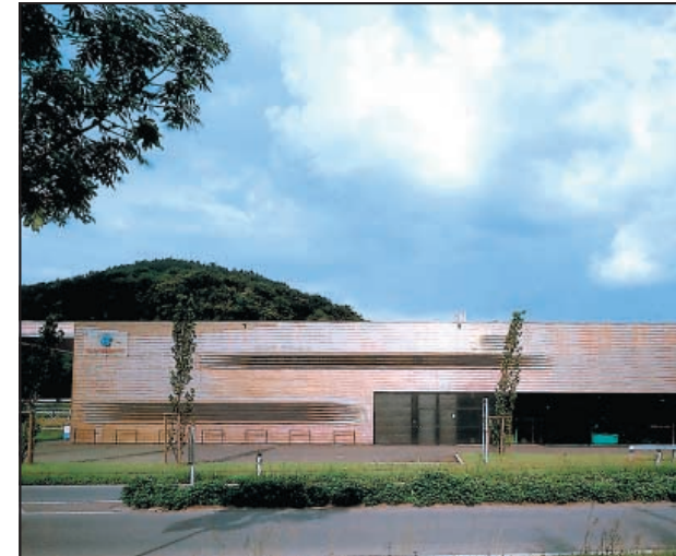
Bauherr: Carmen und Herbert Ebenhoch, Koblach Planung: AIX Architects Egger r Klostermann-Zaffignani, Feldkirch Holzbaubetrieb: Sohm Holzbautechnik GmbH, Alberschwende
