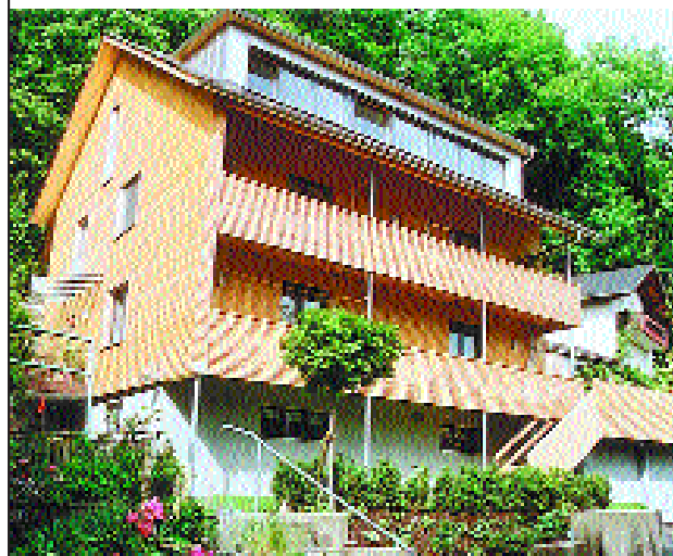
Bauherr: Hansjörg Österle, Kennelbach Planung: Tschabrun Kilian, Muntlix Holzbaubetrieb: Gebhard Berchtold GmbH, Schwarzenberg
