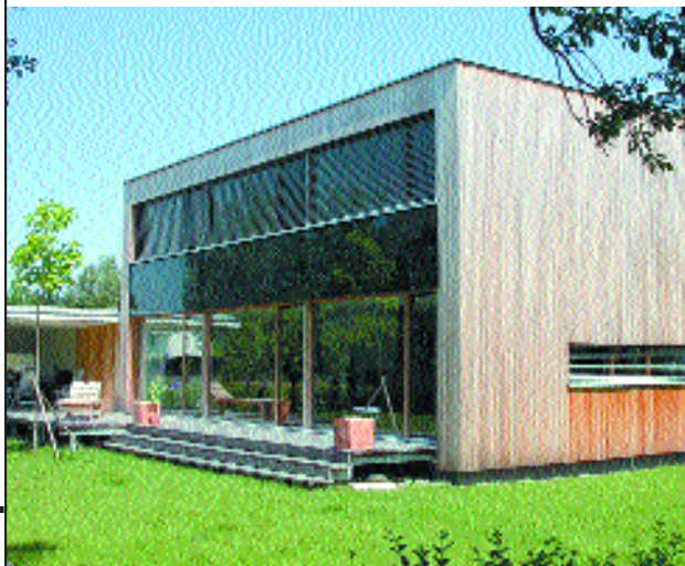
Bauherr: Egger Dieter und Gertrud, Hohenems Planung: BM Hagspiel Jürgen, Lingenau Holzbaubetrieb: Sohm Holzbautechnik GmbH, Alberschwende
