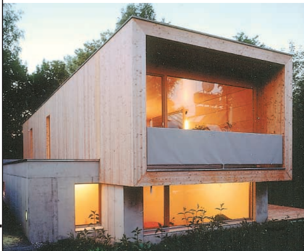
Bauherr: Petra Moosmann und Thomas Hämmerle, Lauterach Planung: DI Hermann Kaufmann, Schwarzach Holzbaubetrieb: Berchtold N. GmbH & Co KG, Wolfurt
